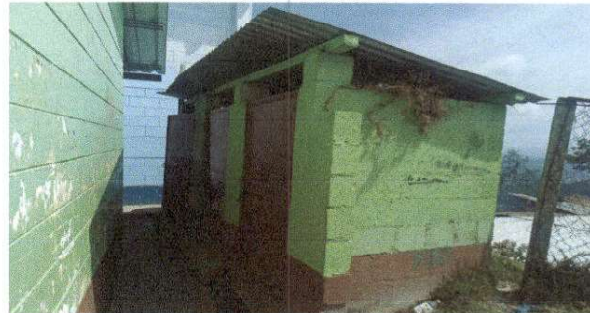
Foto 2: 2 ESTRUCTURA DE DE TECHO. 2.2 Sustitución de estructura de soporte de madera, por metal
