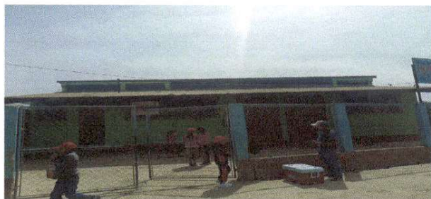
Foto 1: 1. CUBIERTA DE LÁMINA. 1.1 Sustitución de lámina, por lámina troquelada aluzinc calibre 26
